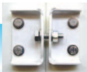
Pincés d'assemblage des modules à rupture de ponts thermiques
